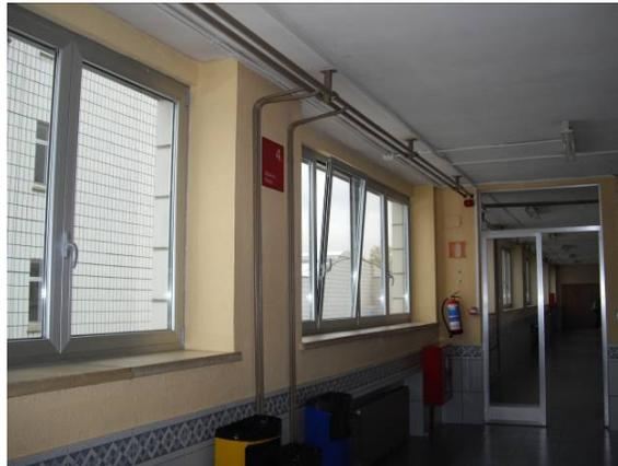
*Tubería de calefacción sin aislar*
