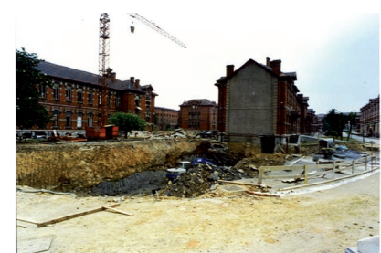
▲ Construcción del túnel Pabellón Jado.
